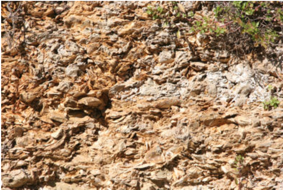
Figura 3.3 – Pormenor da encosta do Alto da Eira
