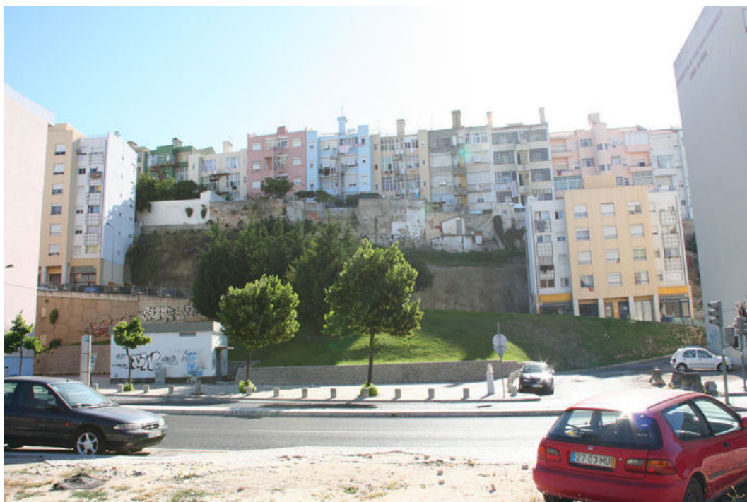
Figura 3.12 – Aspecto do edificado na vertente da Av. a Mouzinho de Albuquerque para o Bairro Lopes (2/2)
