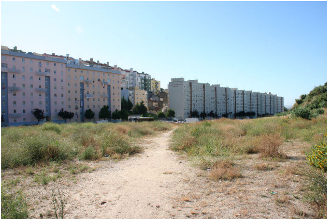
Figura 3.11 – Aspecto do edificado na vertente da Av. a Mouzinho de Albuquerque para o Bairro Lopes (1/2)
