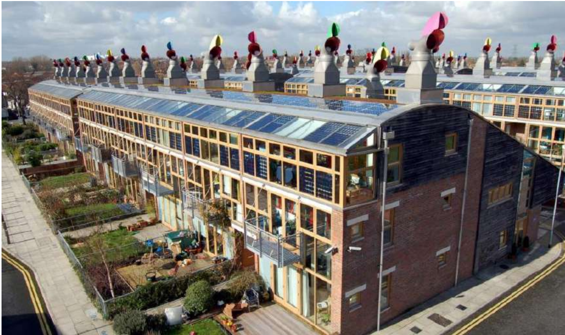
FIGURA 18 – VISTA DOS EDIFÍCIOS DE BEDZED, ONDE É VISÍVEL A UTILIZAÇÃO DE SISTEMAS SOLAR INTEGRADOS NAS SOLUÇÕES CONSTRUTIVAS DOS EDIFÍCIOS
