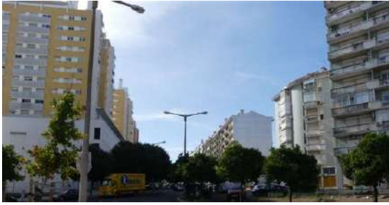
Figura 4 – Av. Coronel Eduardo Galhardo (edifícios com mais de 10 pisos)
