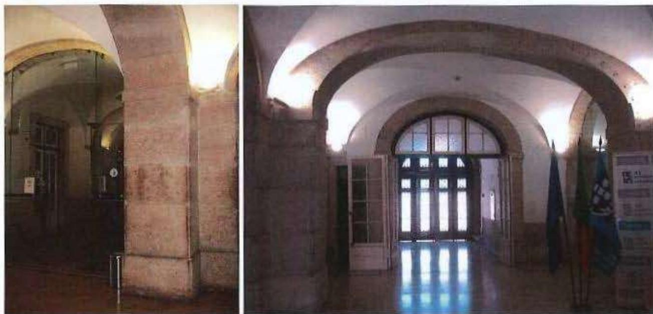
Fig. 25 – Sistemas de arcos rebaixados no corpo central do piso térreo.
