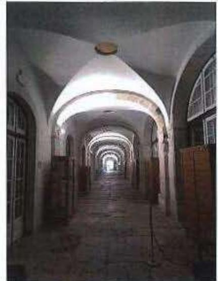
Fig. 30 – Boeiros (hoje cobertos) rasgados nas abóbadas do piso térreo. Por eles se faria o escoamento de cereais dos pisos superiores para os vagões de transporte.
