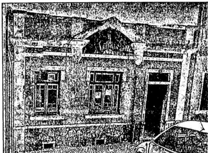
Foto 1 Fachada do edifício na Rua Dom Álvaro de Castro, nº 51, no Bairro de Santos, Lisboa
