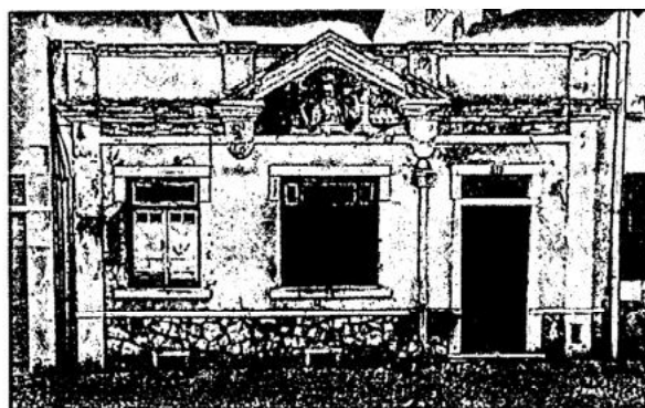
Figura 2 - Fotografia da fachada do imóvel
