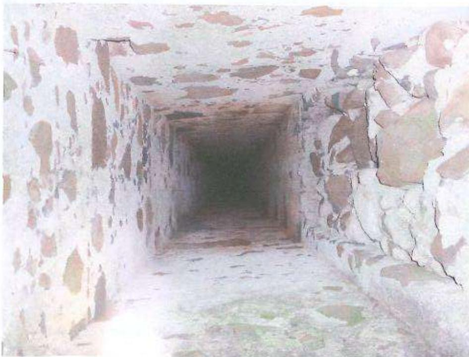
Foto 10 – Aspeto do interior do respiradouro/poço de visita MP4, observando-se no lado direito a porta entaipada. Foto tirada a partir da abertura na cobertura.
