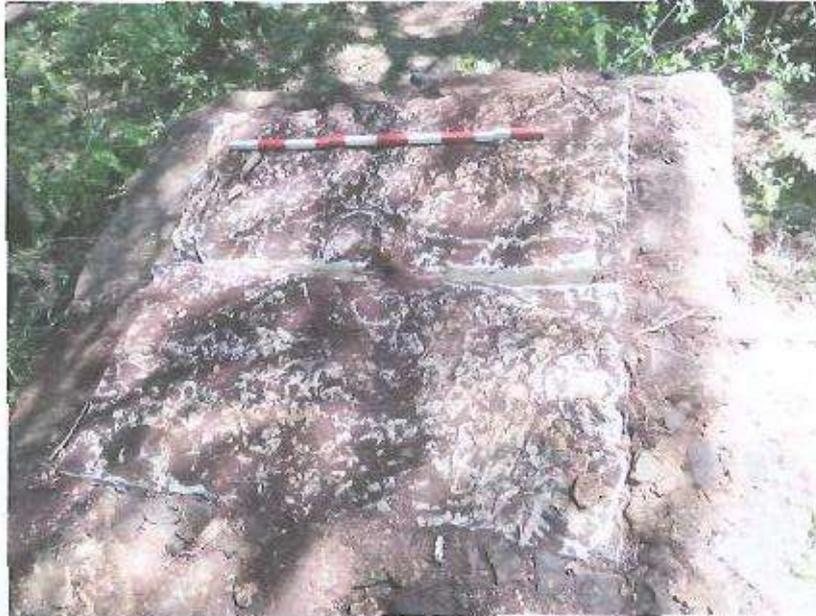
Foto 3 – Cobertura do poço de visita MP2 com lajes calcárias.
