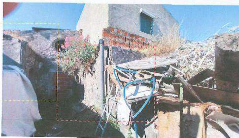
Foto 29 – Alçado da arca d'água (sinalizada a tracejado vermelho), e alçado edifício anexo (sinalizado a tracejado amarelo). Na imagem identifica-se ainda a *construção ilegal* (representar em tracejado de outra cor) erguida sobre a cisterna. (vista a partir do pátio localizado a Sul).
