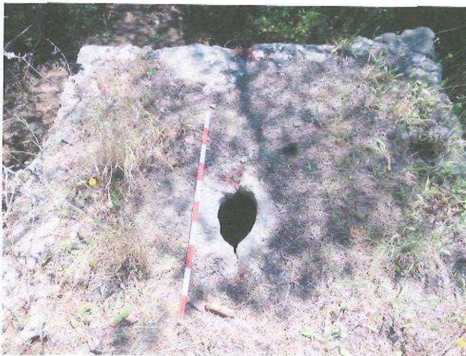
Foto 9 – Cobertura do respiradouro/poço de visita MP4 onde se observa uma abertura.
