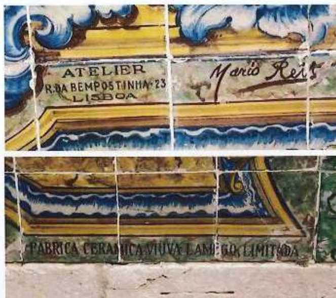
Fig. 13 – Detalhes dos painéis de azulejos do Chafariz da Junqueira.
