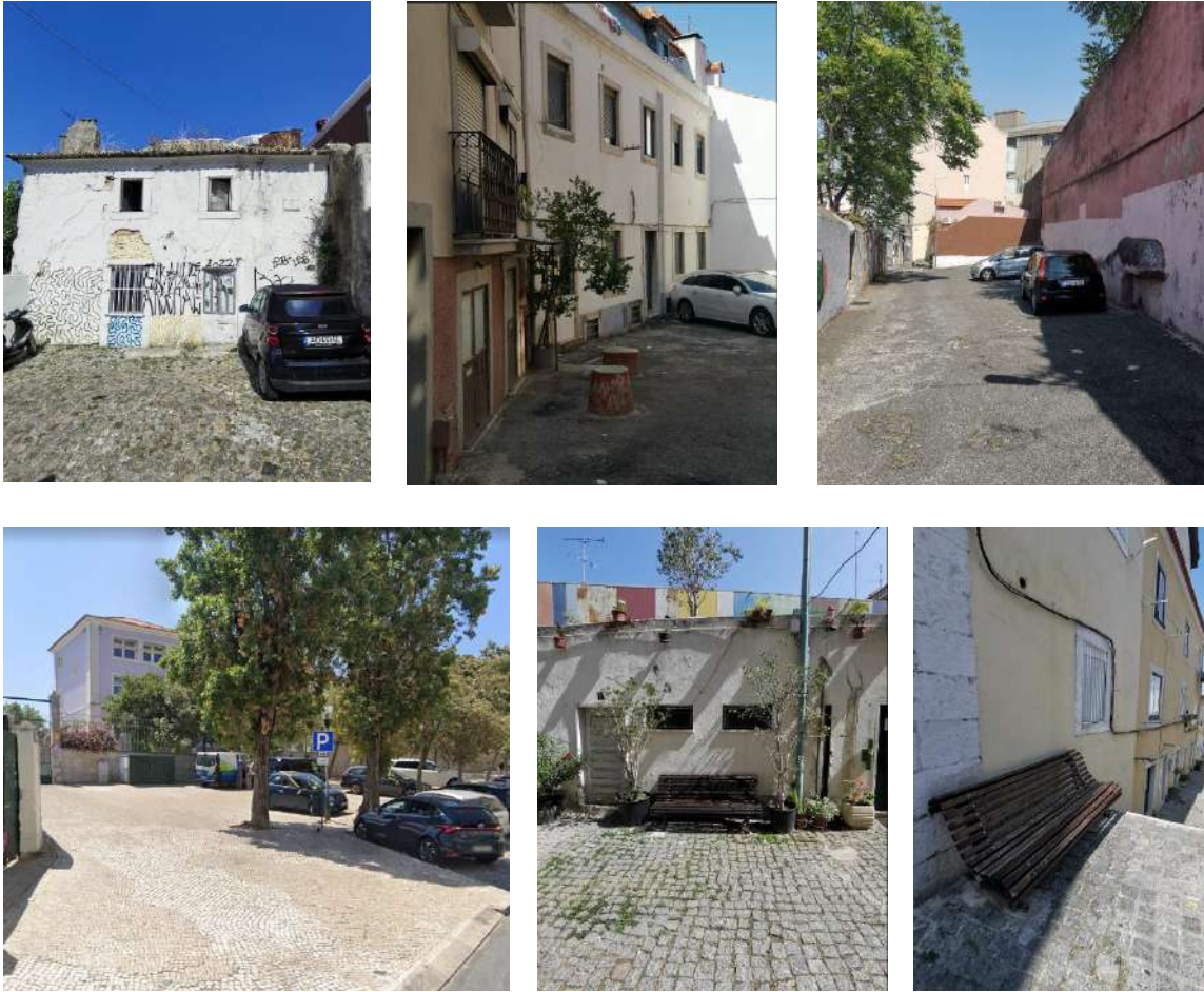
Figura 26- Aspetos do Espaço Público
