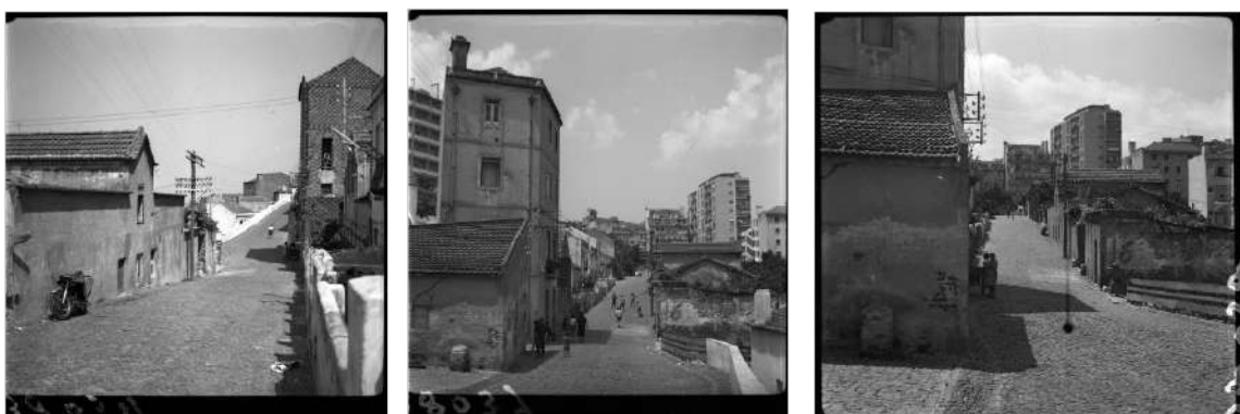
Figura 22 - Fotografias da Rua C da Quinta do Ferro, junho de 1962. Autor: Bastos, Artur Inácio; Fonte: Arquivo Fotográfico – AML. PT/AMLSB/CMLSBAH/PCSP/004/AIB/000298, PT/AMLSB/CMLSBAH/PCSP/004/AIB/000301, PT/AMLSB/CMLSBAH/PCSP/004/AIB/000302
