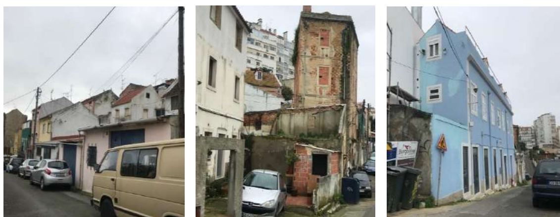
Figura 30 - Exemplos do edificado na área de intervenção: Rua C
