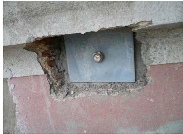
**Pormenor de ligação entre as asnas A1a, A1b, A2a e A2b e o pavimento de madeira do piso 2 - Alçado**
