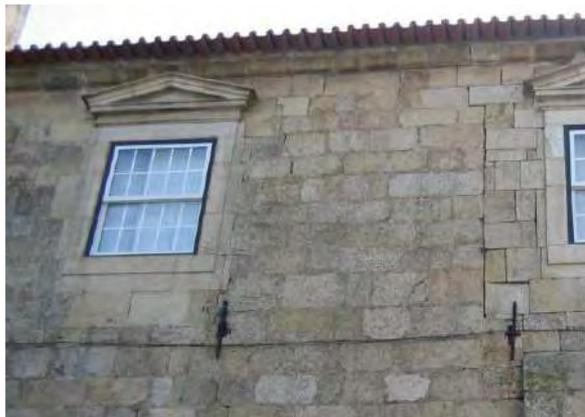
Ancoragem em alvenaria fraca qualidade
