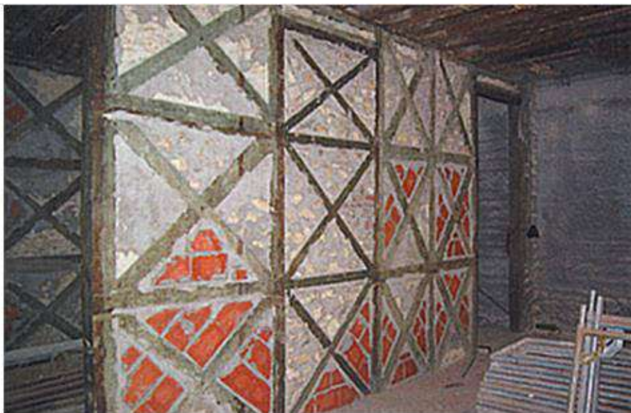
Figura 2 - Reparação de frontal com substituição das alvenarias degradadas por alvenaria nova (V. Córias)
